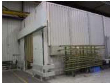
Bild 15: Strahlenschutzbunker nach Umsetzung
